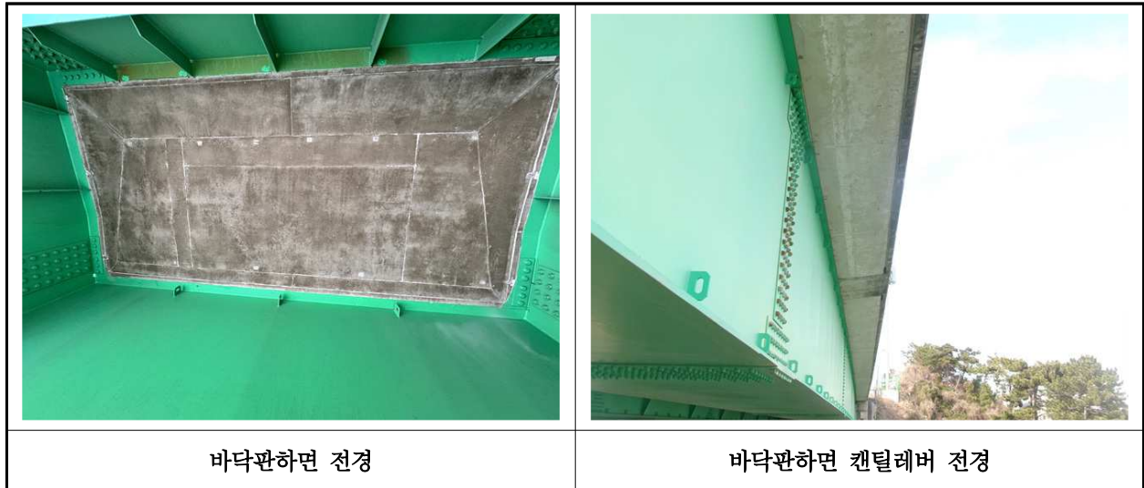
【사진 4.3.2】 바닥판하면 전경
