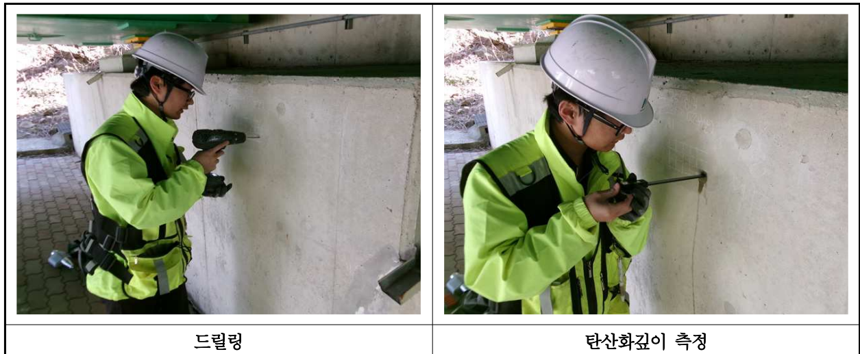
【사진 4.4.3】 탄산화 깊이 측정 현장사진
