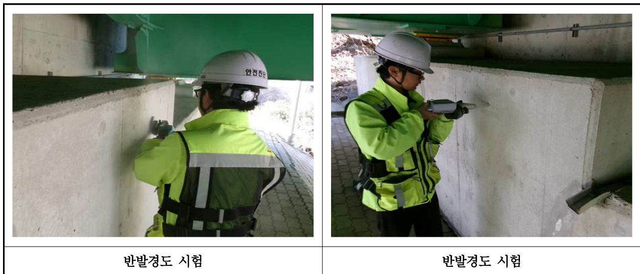
【사진 4.4.2】 반발경도시험 현장사진
