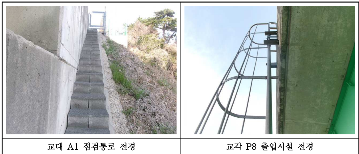
【사진 4.3.26】 교량 점검시설 전경
