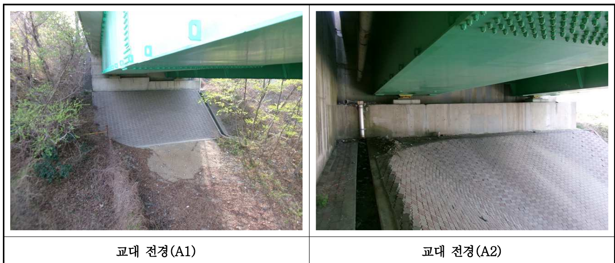
【사진 4.3.8】 교대 전경
