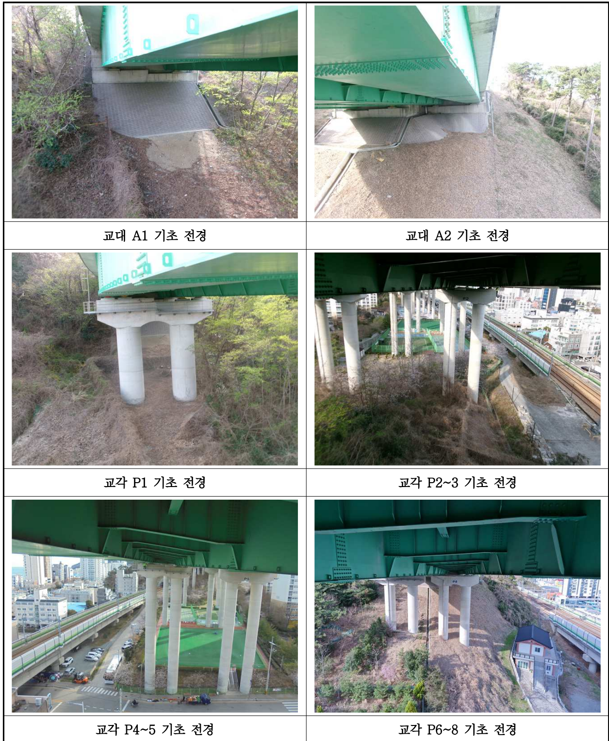
【사진 4.3.12】 기초 전경
