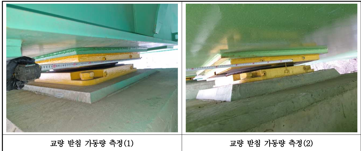
【사진 4.3.16】 교량받침 이동량 측정
