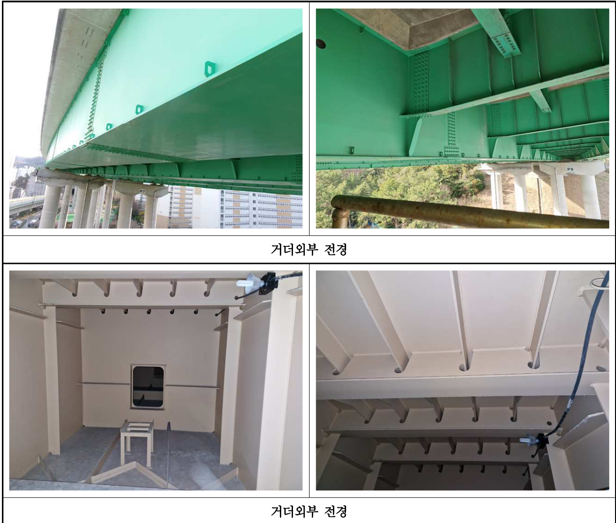
【사진 4.3.4】 거더 전경
