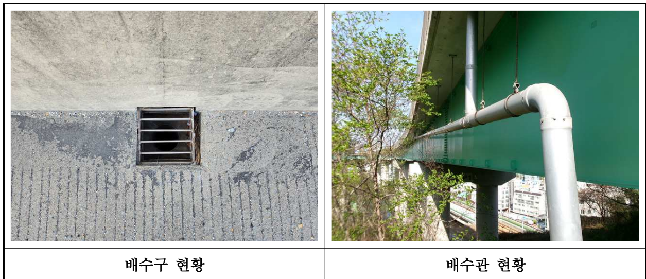
【사진 4.3.22】 배수시설 전경
