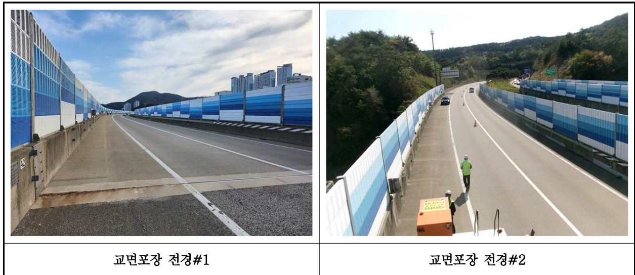
【사진 4.3.20】 교면포장 전경
