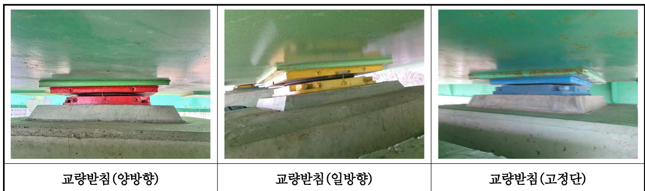
【사진 4.3.13】 교량받침 전경
