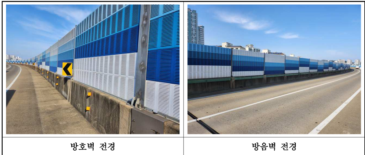
【사진 4.3.24】 방호벽 및 중분대 전경
