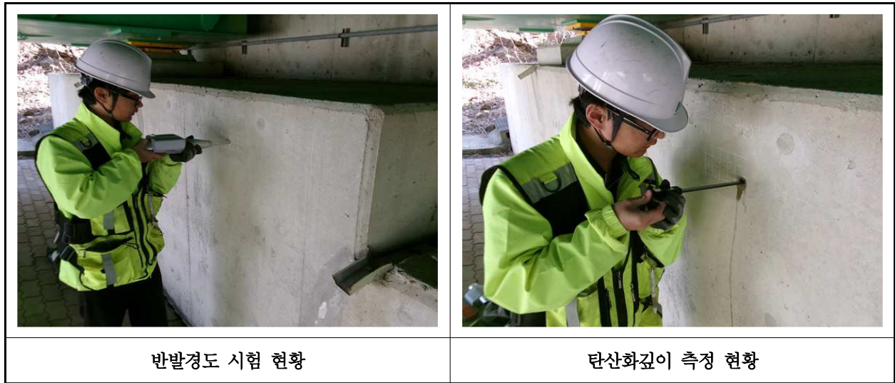
【사진 4.4.1】 콘크리트 내구성조사 현황
